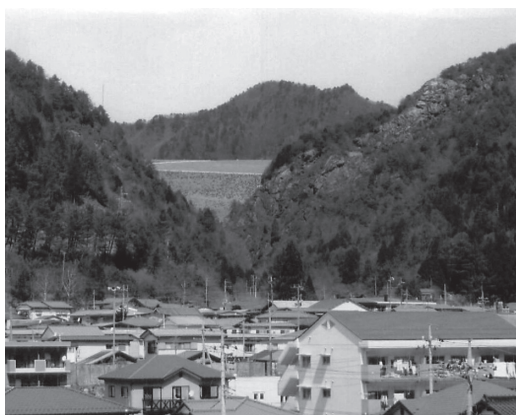
写真9 危険な箕子橋堆積場（現在使用中）。1960年に完成した。高さおよそ110m、約700万㎡の鉱滓が堆積している。
