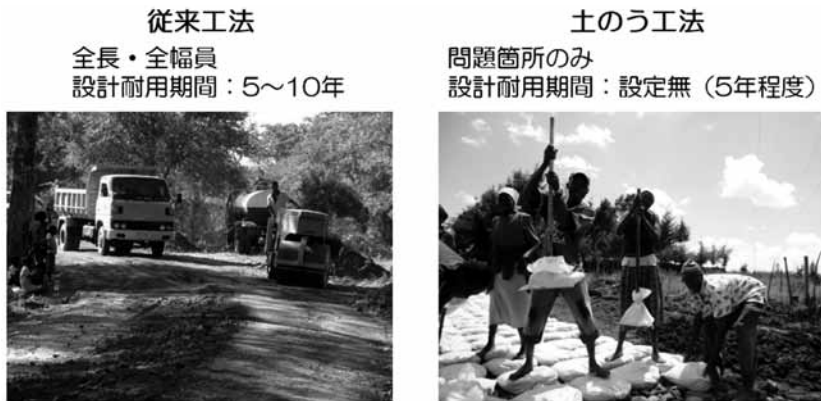
図2 従来工法と土のう工法
