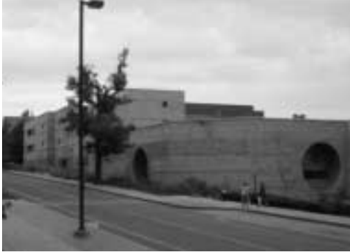
工事が終了した部分のILR
