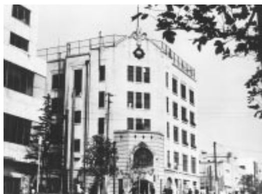
神田駿河台・政経ビル全景
